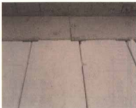
内墙竖板顶部连接构造示例图
