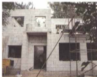
砌块低层承重结构工程示例图
