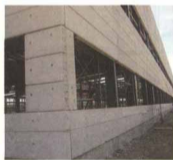
钢结构外墙横板示例图
