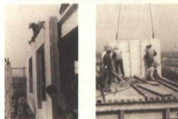
拼装大板吊装及安装示例图
