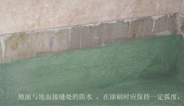
地面与地面接缝处的防水 , 在涂刷时应保持一定弧度, 避免直角, 衔接紧密, 卫生间墙面防水涂刷高度不得低于 1800mm
