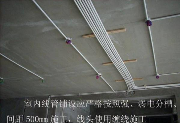
间距 500mm 施工,线头使用缠绕施工
