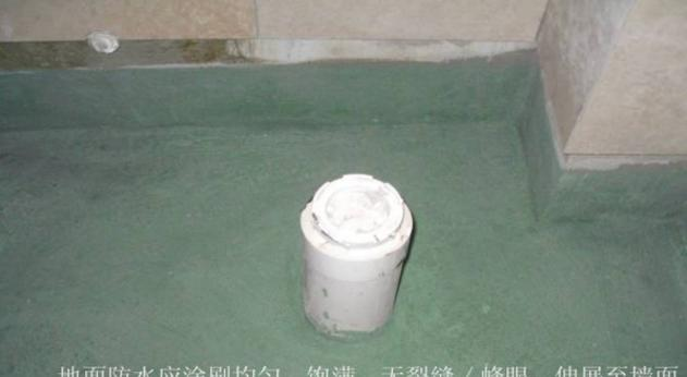
地面防水应涂刷均匀,饱满,无裂缝/蜂眼,伸展至墙面时反高大于300mm,主排水管道口封闭,避免建渣掉落造成堵塞
