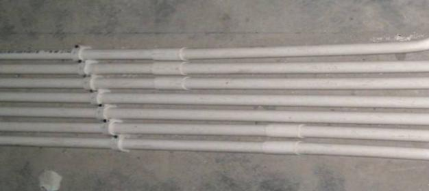
大量线卡并置时,须使用专用线卡固定,使 线管更加稳固
