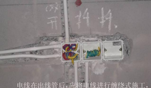
电线在出线管后,应将电线进行缠绕式施工, 末梢裸露铜线部分必须用专用绝缘胶布进行封裹
